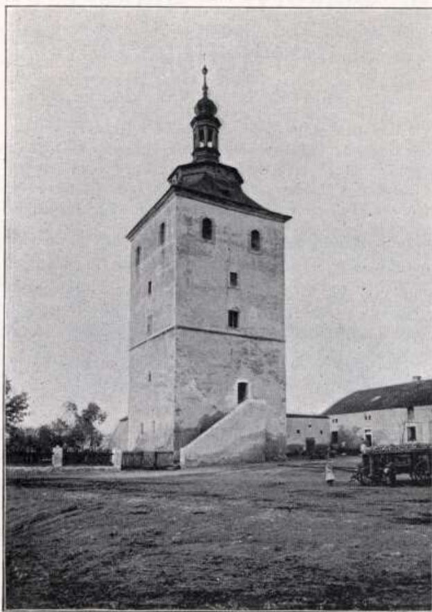
Obr. 63. Hrušov. Věž býv. tvrze.
